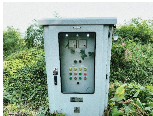
ภาพที่ 2-18 ที่ตั้ง และตู้ควบคุมบ่อน้ำภายในโครงการ
