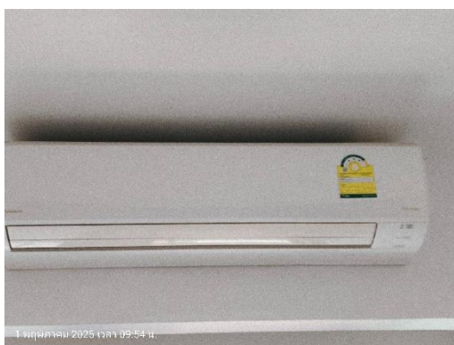
เครื่องปรับอากาศแบบแยกส่วน ( Split Type )
