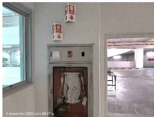
ตู้ FHC, ป้ายแสดงวิธีการใช้อุปกรณ์ดับเพลิง ไฟฉุกเฉิน กริ่งเตือนภัย ที่ตั้งกรณีเกิดเหตุเพลิงไหม้
