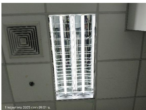
ใช้หลอดไฟประหยัดพลังงานและโคมไฟสะท้อนแสง
